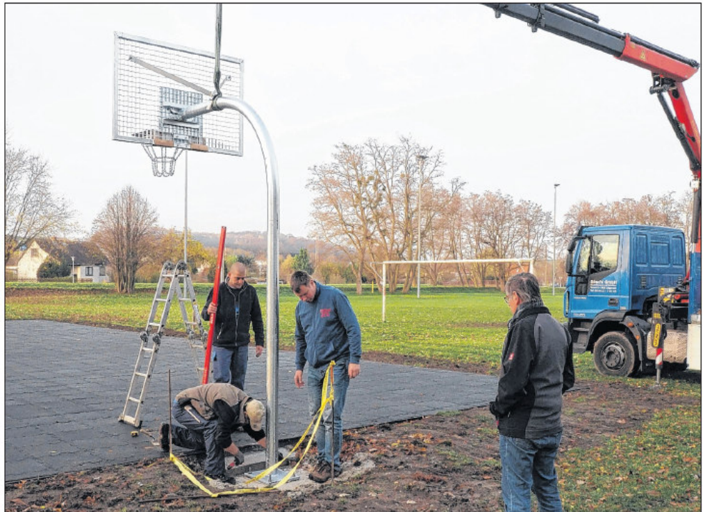
Die Streetballständer werden von den Schlossern aufgestellt. Die Körbe hängen exakt 3,05 Meter hoch.
