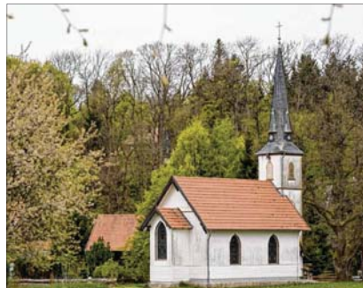
Das Gotteshaus, das am 27. Juni 1897 geweiht wurde, muss dringend saniert werden. Fotos (3): Frank Drechsler
