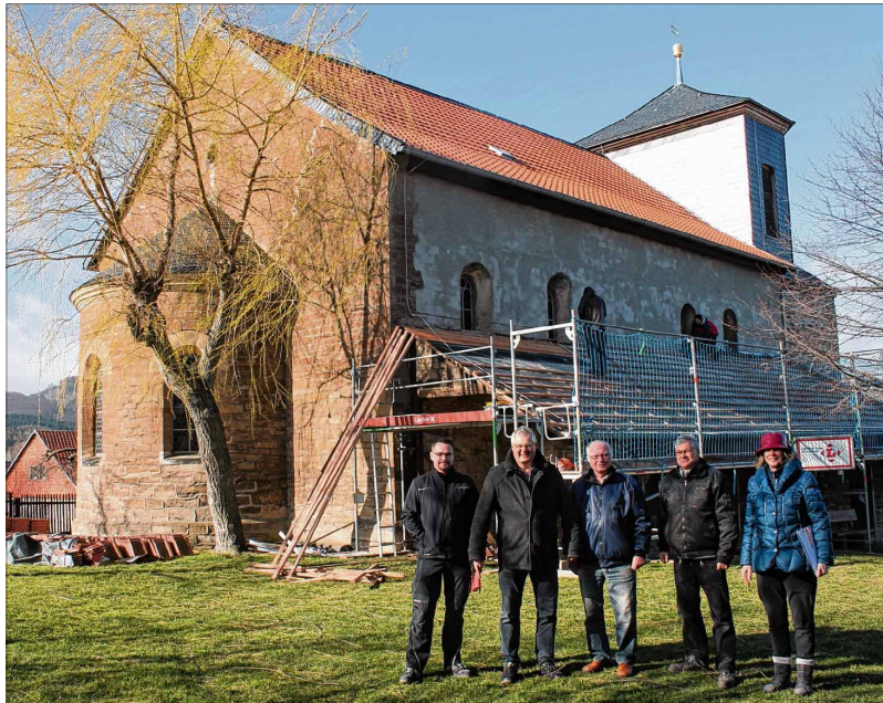
Die Katharinenkirche wird saniert. Gestern Morgen begann dies mit einer Baubesprechung an der (von links) Christian Rasche, Stephan Schädel, Erhard Niehoff, Jens Groß und Elke Weirich teilnehmen. Fotos (3): Jörg Niemann
