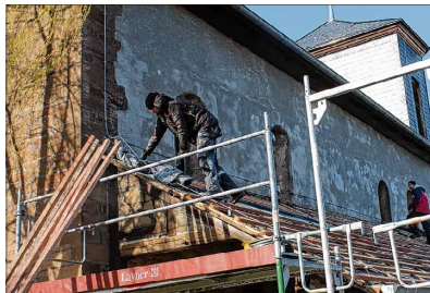
Das Vordach der Kirche wird zunächst demontiert, damit ein neues Gerüst aufgestellt werden kann.
