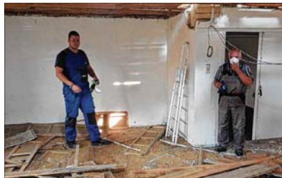
Auch selbst legen die Vereinsmitglieder kräftig Hand beim Umbau an. Hier Bernd Grube (rechts) und Erik Weihe beim Abriss der desolaten Decke im „Grenz-zimmer“.
