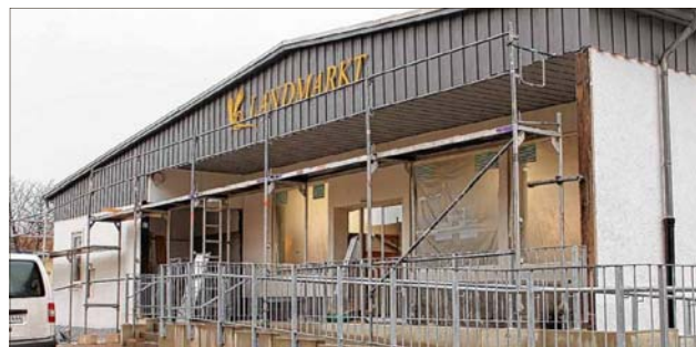
Seit wenigen Tagen ist auch von außen sichtbar, was hier in Kürze eröffnen wird.
