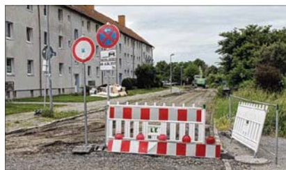
Die Ilsenburger Karlstraße wird grundhaft ausgebaut und ist daher ab sofort voll gesperrt. Foto: Jörg Niemann
