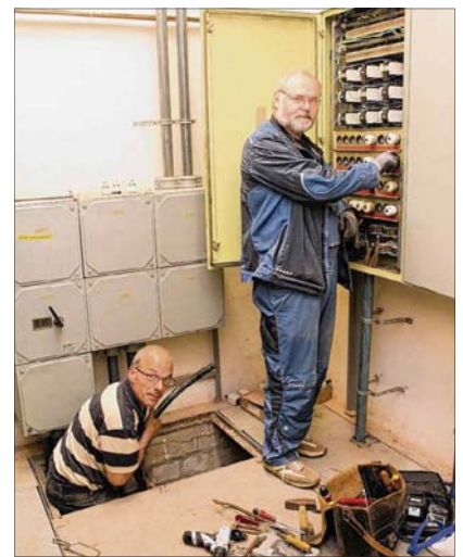
Die alte elektrische Anlage der Kaufhalle wird von Werner Förster (links) und Norbert Krause demontiert. Foto: Jörg Niemann
