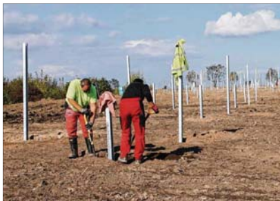
Auf der Deponie Pfingstanger zwischen Stapelburg und Abbenrode hat der Aufbau eines Solarparks begonnen. Foto: Jörg Niemann
